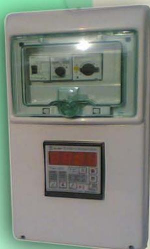
*Il quadro è di tipo SCHNEIDER IP65 con moduli di controllo Tiny21T, Tiny23T o Tiny24T.*
