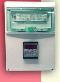
Il quadro è di tipo SCHNEIDER IP65 con modulo di controllo Tiny 4X.
